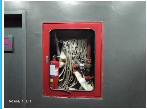
รูปที่ 3-50 ตู้เก็บอุปกรณ์ดับเพลิงบริเวณฟิตเนส
