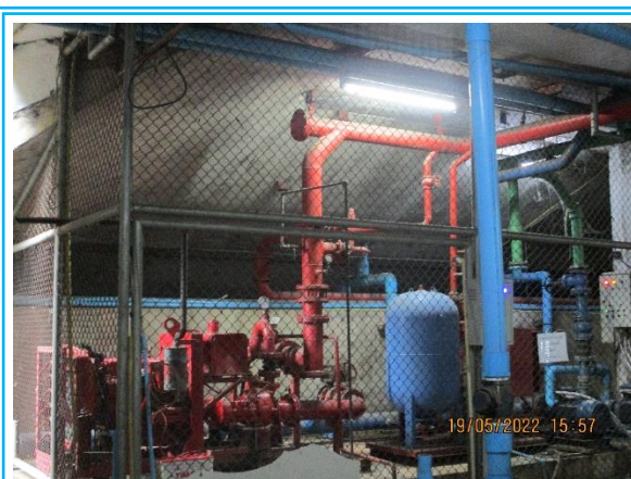
รูปที่ 3-47 ระบบปั้มน้ำดับเพลิง
