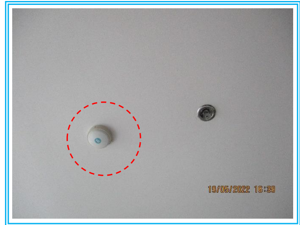
รูปที่ 3-55 เครื่องตรวจจับความร้อน
